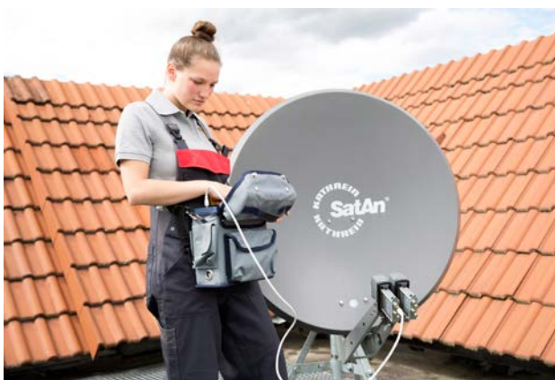
Abbildung 6: Arbeiten an einer Satellitenanlage (Quelle: ZVEH)
